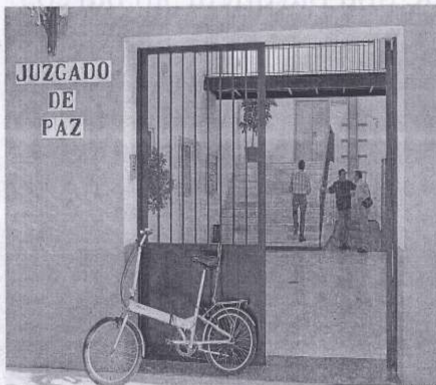
Una imagen del exterior de las nuevas instalaciones del Juzgado de Paz de Bormujos.
